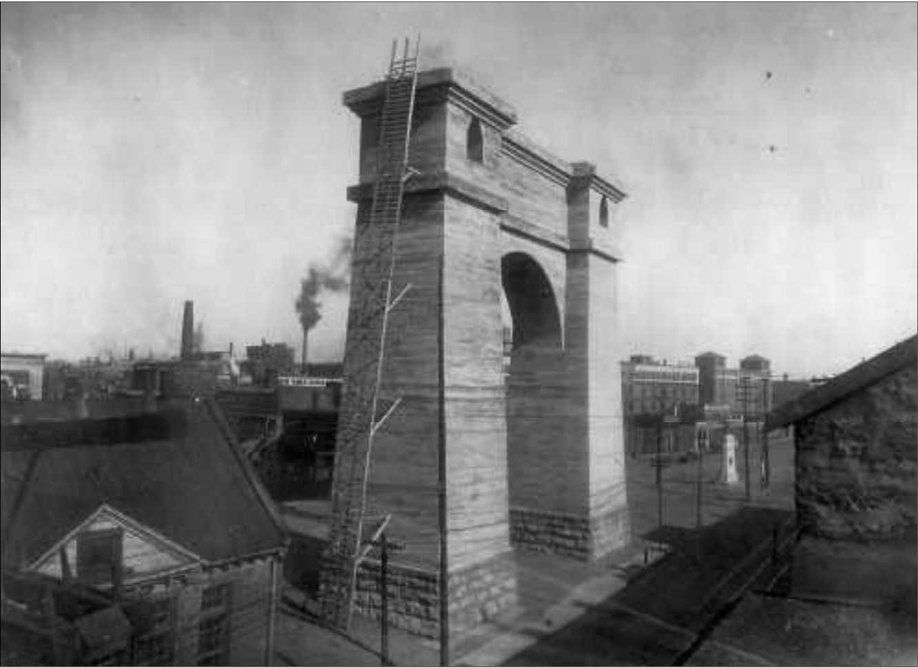
LE PILIER NO 26 INAUGURANT LA CONSTRUCTION DU PONT JACQUES-CARTIER.
